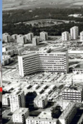
Conçu par les architectes Arretche et Forestier, le Centre des Chèques Postaux est édifié à La Source en 1968. Construit sur un plan en X, il présente une ossature en béton armé et s'inscrit dans le courant fonctionnaliste.
